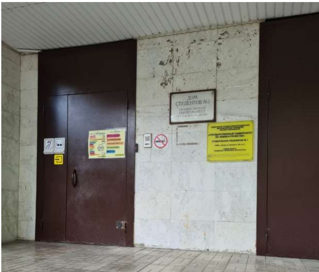
Фото главного входа в общежитие.
