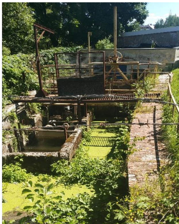
Рисунки 3.19–3.20 Современное состояние осушительной насосной станции
